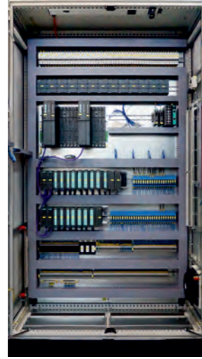
Шкаф управления линией дозирования йогуртов ОАО «Вимм-Билль-Данн»
