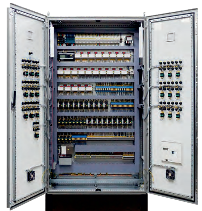
Шкаф управления приточно-вытяжной вентиляцией Honeywell Building Solution
