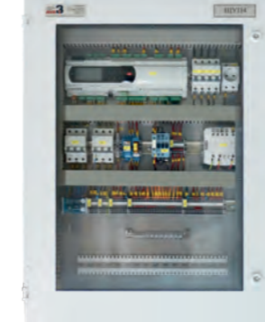
Шкаф RAHU рециркуляционно-вентиляционная установка
