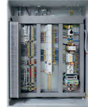
Шкаф RAHU рециркуляционно-вентиляционная установка
