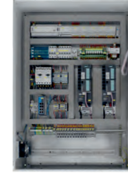
Щит управления насосами теплового пункта
