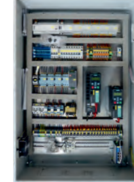
Щит управления насосами теплового пункта
